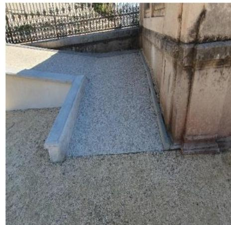
Le palier de repos de la rampe est trop petit, et la pente est trop inclinée. Elle n'est pas protégée par un garde-corps et il n'y a pas de bande d'éveil au droit de l'escalier.
