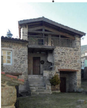
Exemple de débord de toiture
