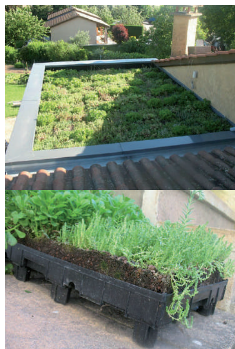
Exemple de toiture-terrasse végétalisée et bacs pré-cultivés
