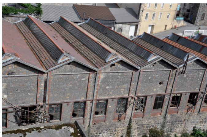
Exemple de toiture à shed
