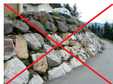
Exemple d'enrochements de type cyclopéen
