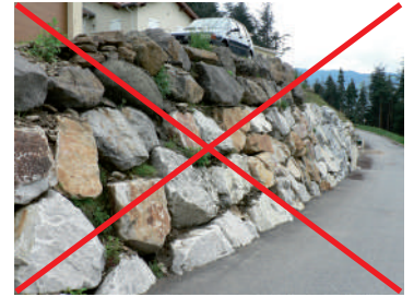
Exemple d'enrochements de type cyclopéen
